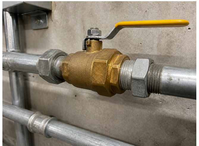
Nach der Inspektion
